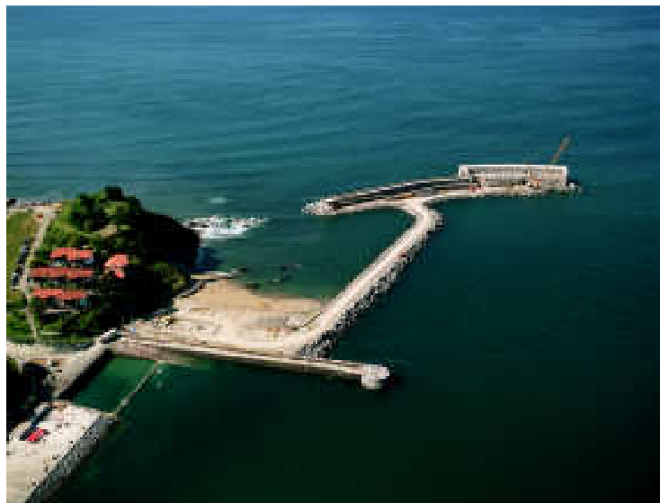
Situación de la obra a junio de 2008
