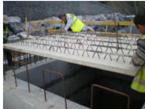
Disposición del encofrado perdido
