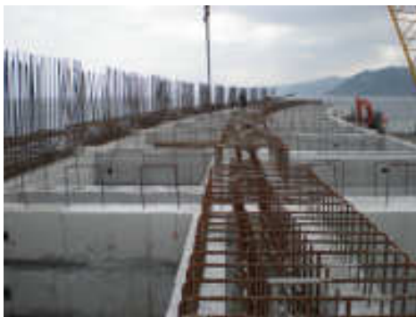
Columnas previo al cierre
