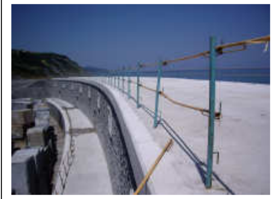
Vista exterior de la galería con mampostería e imposta
