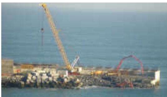
Diferentes momentos de la ejecución de la galería de las turbinas
