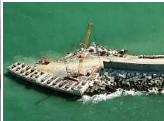
Central y dique unidas
