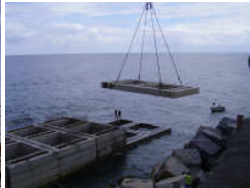
Colocación de las piezas
